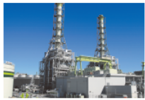
川崎天然ガス発電所
